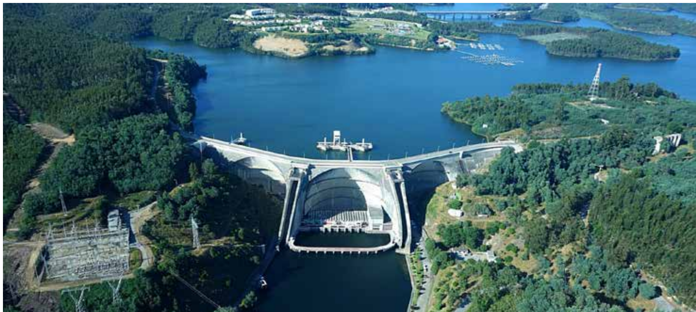
Barragem da Aguieira
